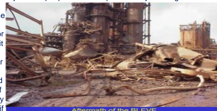
Aftermath of the BLEVE
